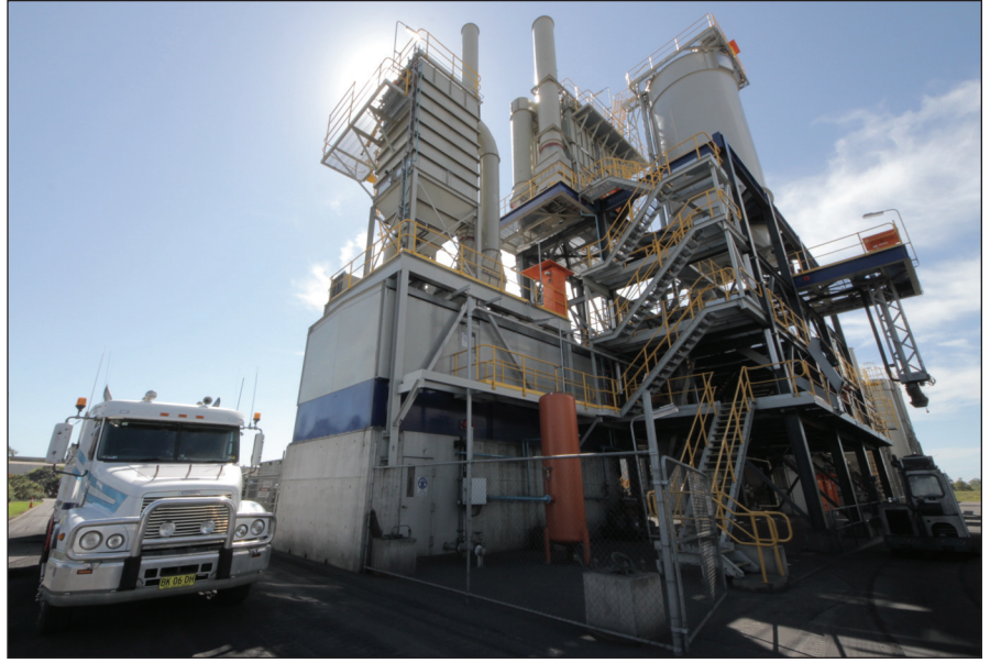
الشكل (2): التصميم المبتكر للوحدات التي تصنعها شركة ريغاين فائدة كبيرة في وضع المنشآت في الموقع.
